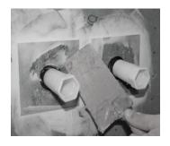
Dichtmanschette WIM-SWM 120 vollflächig und luftblasenfrei auf der Abdichtungsbahn aufbringen. Trocknungszeiten sind abhängig von der Raumtemperatur, diese können bis zu 16 Stunden betragen.
