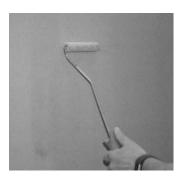
Saugende Untergründe (Kalkzementputz, Gipskartonplatten) mittels geeigneter Grundierung vollflächig grundieren. Alle haftungsmindernden Bestandteile sind zu entfernen. Die Grundierung trocknen lassen. Bitte beachten Sie die jeweiligen Verarbeitungshinweise des Herstellers.
