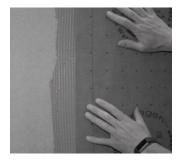
Abdichtungsbahn BIBER-BD20 vollflächig auf den Untergrund aufbringen. Mit geeignetem Werkzeug (Glätter oder Malerspachtel) die Bahn vollflächig von oben nach unten auflegen und abstreichen. Lufteinschlüsse sind zu vermeiden.
