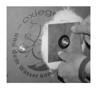
Dichtmanschette WIM-SWM 120 mit dem flexiblen Mittelteil luftblasenfrei über die Rohrverlängerung ziehen. Dichtmanschette WIM-SWM 120 nicht auf den Baustopfen sondern nur auf der Rohrverlängerung aufbringen.
