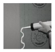
Bei Überlappungen von Bahnen den im Lieferumfang enthaltenen Polymerkleber OX-MS 1K auf dem seitlich markierten Streifen aufbringen.
