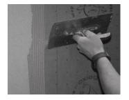
Mit der zahnlosen Seite des Glätters oder Malerspachtels alle Lufteinschlüsse von der Mitte aus ausstreichen. Trocknungszeiten sind abhängig von der Raumtemperatur, diese können bis zu 16 Stunden betragen.
