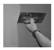
Fliesenkleber der Klassifizierung mind. C2 TE S1 mit einer 4 mm Blockzahnung auf den grundierten Untergrund 5 cm breiter als die Abdichtungsbahn BIBER-BD20 aufbringen. Überschüssigen Kleber nach Aufbringen der Abdichtungsbahn entfernen.
